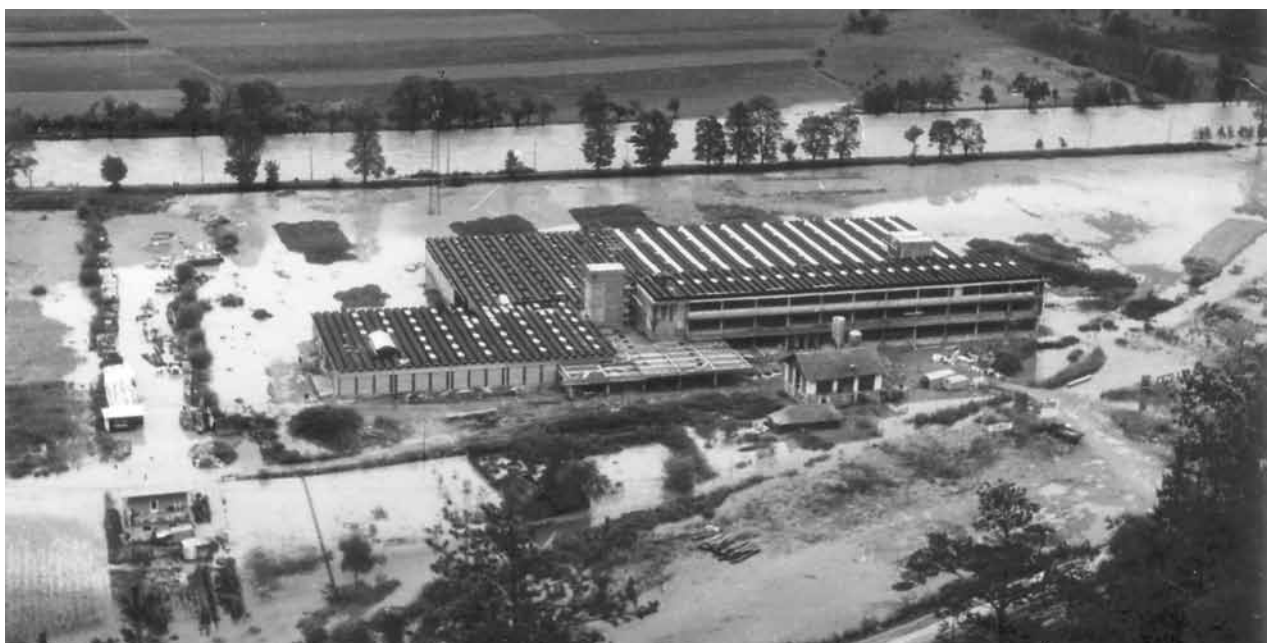
Abb. 2-3: Die Industriezone Brixen während des Hochwassers 1966.
