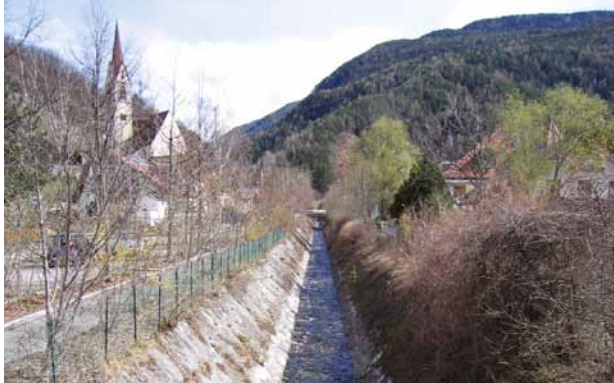
Abb. 2-13: Hart verbauter Zubringerbach.
