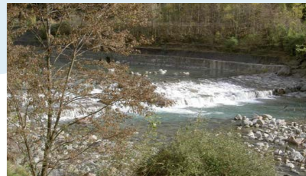
Sperre im Eisack bei Barbiano, Zustand 2013 Sbarramento nell'Isarco presso Barbiano, situazione 2013
