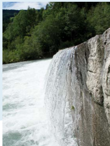
Für Fische unüberwindbare Sperre im Flussbett Sbarramento artificiale nell'alveo fluviale
