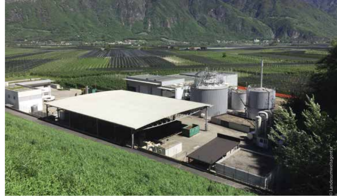
Die Biomüll- vergärungsanlage in Lana
