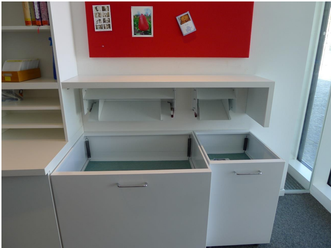
Vom Tischler gebaute Wägen mit Federboden an der Rückseite der Klappen
