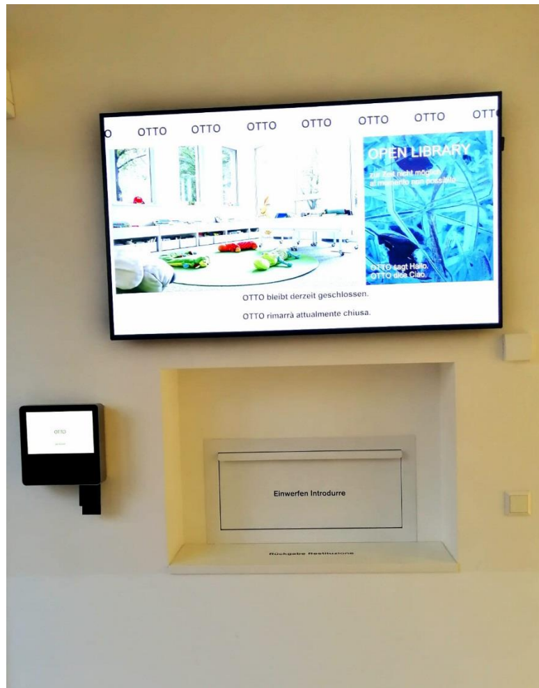
Über den Windfang zugängliche Rückgabeklappe mit Infoscreen und Zutrittskontrolle Open Library
