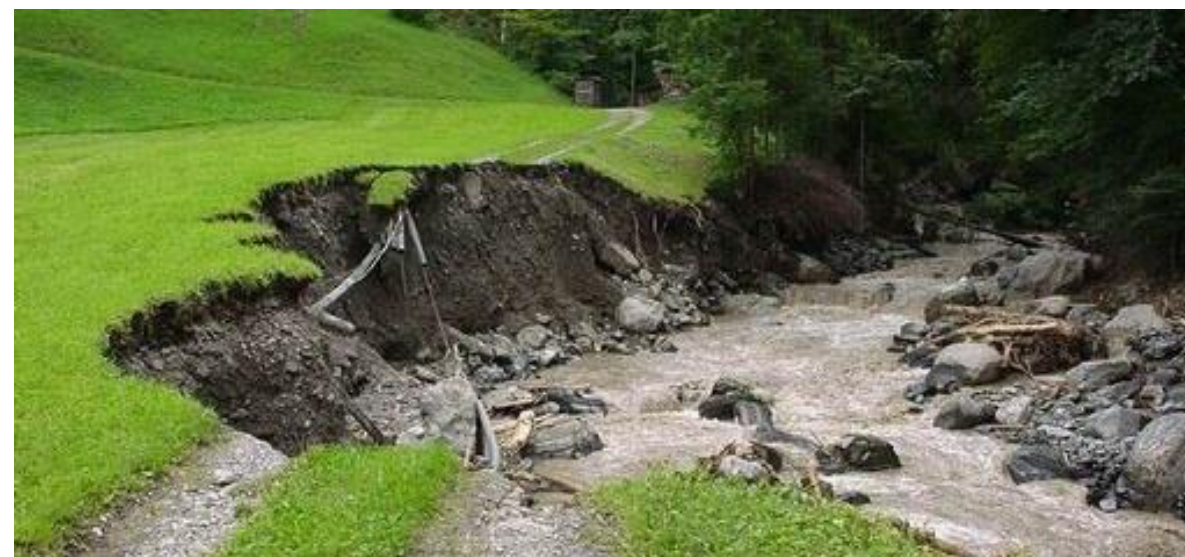
Erosionsschutz / Difesa dall'erosione
