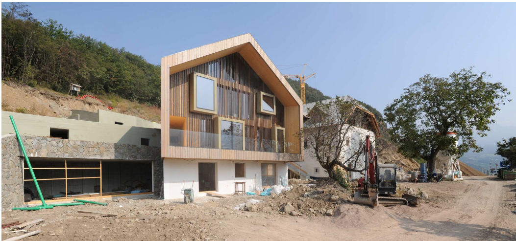
im Bau Realizzazione in corso
