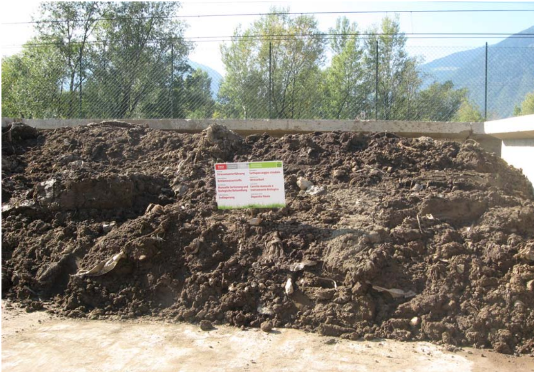
Figura 6: Deposito temporaneo, in uno dei box aperti, di terre provenienti da sottofondo stradale con problemi di inquinamento da idrocarburi, da avviare al trattamento biologico.
