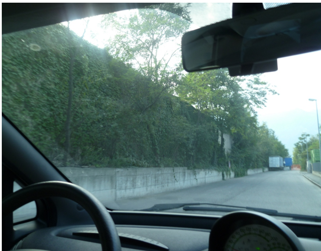
Figura 61 - Muro perimetrale lungo la via Montecatini
