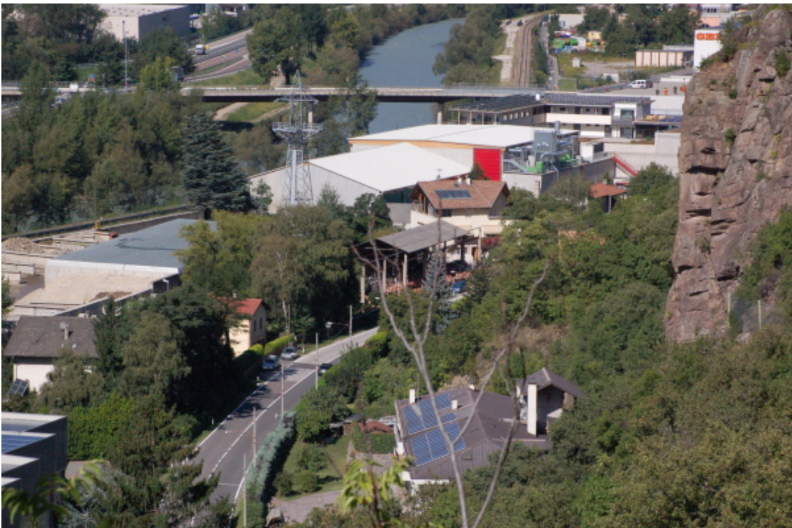
Figura 15: Capannoni 1 e 2 REM-TEC
