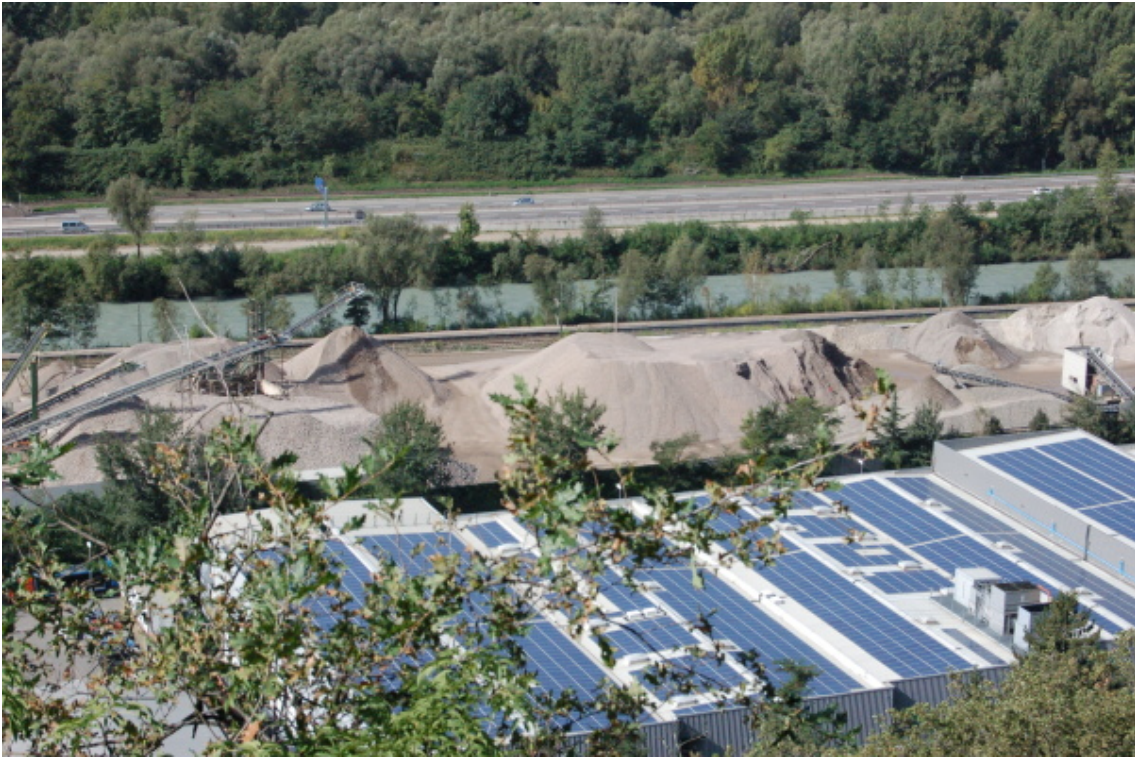
Figura 12: Area lavorazione terre ERDBAU
