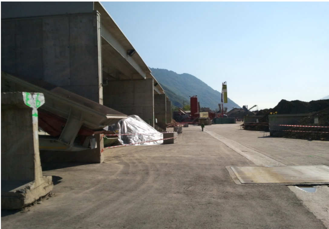
Figura 5: Vista del piazzale con i box coperti sulla sinistra e alcuni i box aperti sulla destra; sullo sfondo i macchinari della ERDBAU con cui REM-TEC lavora in sinergia.
