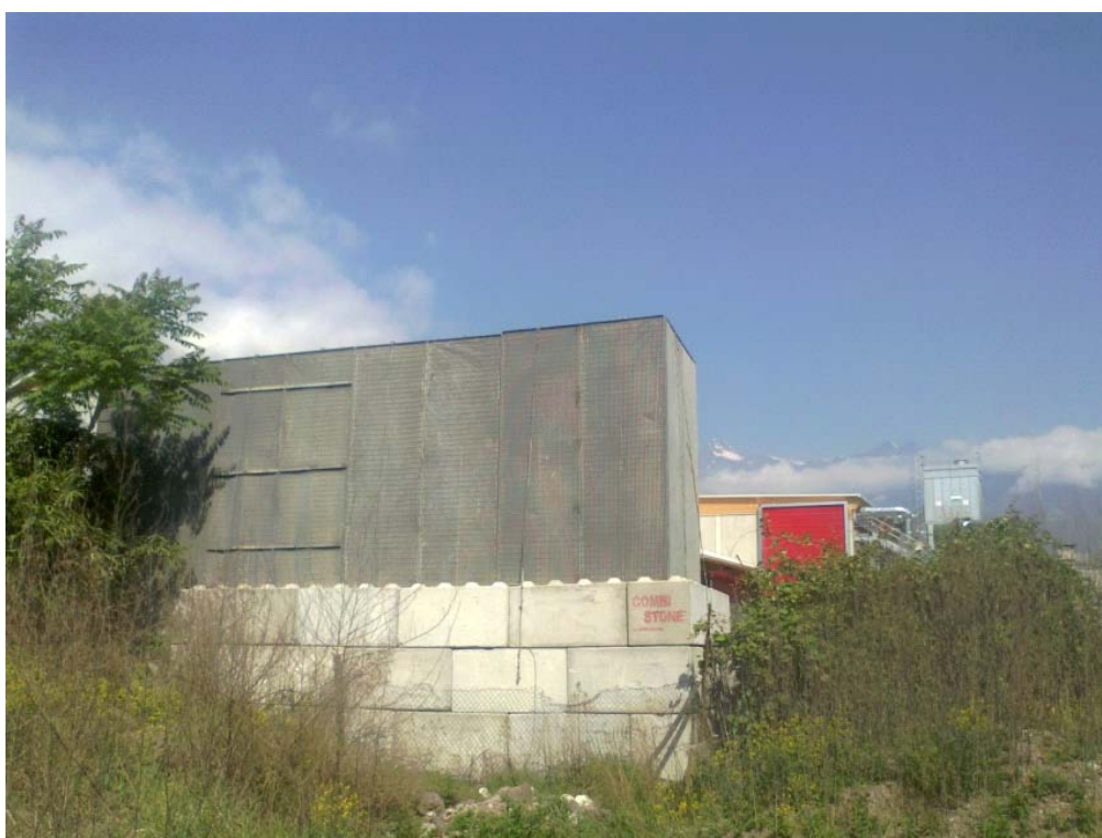
Figura 63 - Muro perimetrale antirumore provvisorio al confine della ditta REM-TEC
