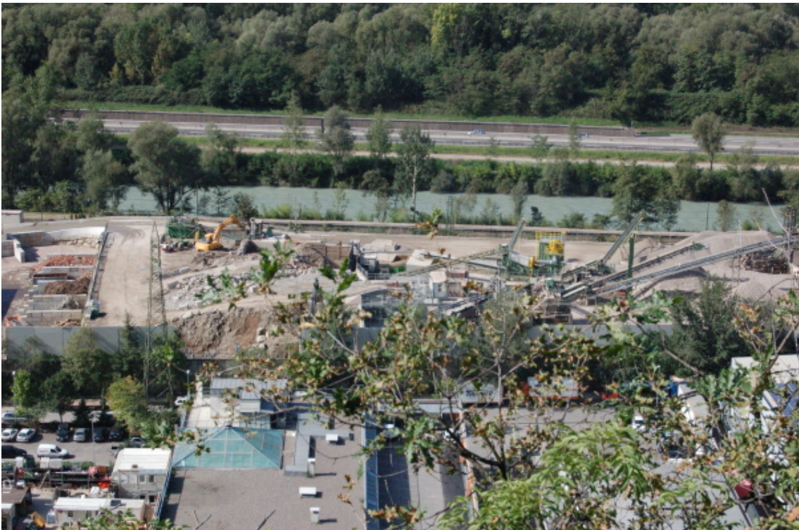
Figura 11: Area lavorazione terre ERDBAU
