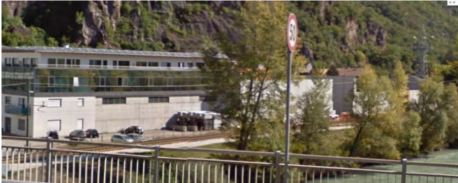
Figura 4: Vista dal ponte sull'Adige (Nord-Ovest): si individua il muro di delimitazione a confine con la linea ferroviaria a tergo del capannone 1.
