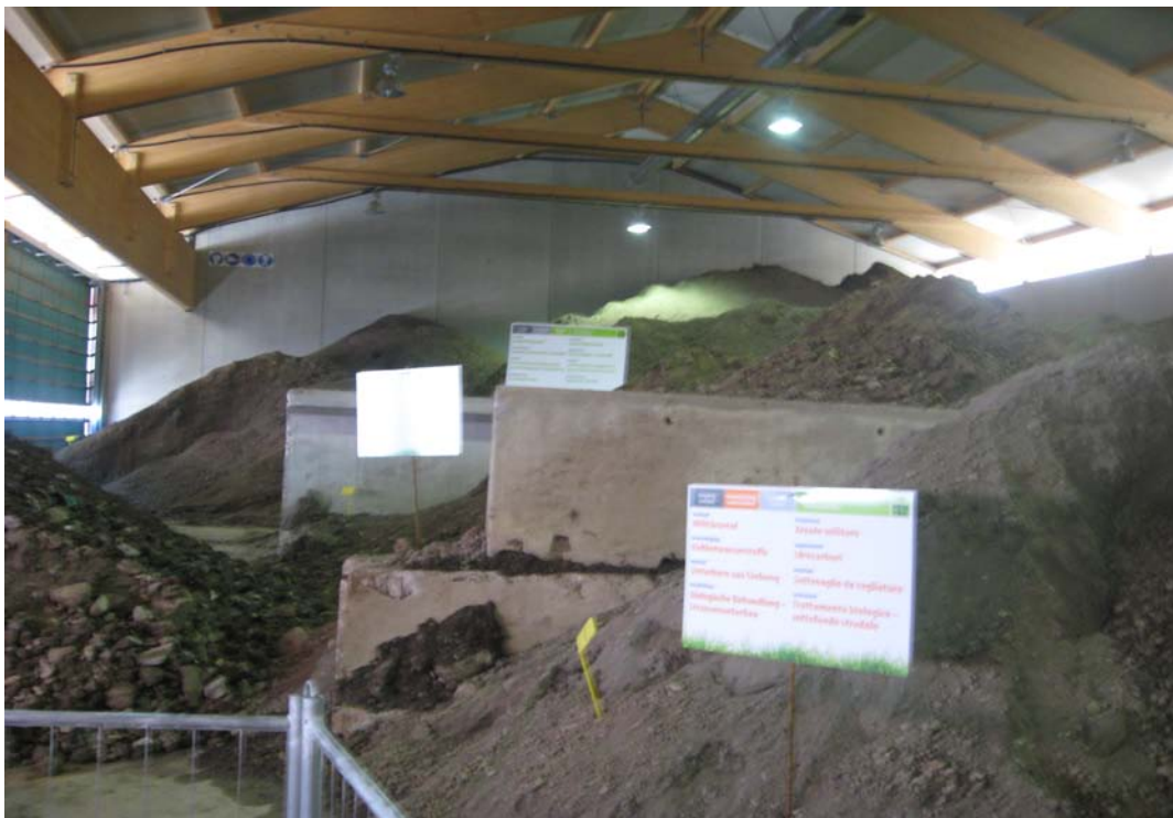
Figura 8: L'interno del capannone 2 con i diversi cumuli disposti per la bioremediation. Si notano sul soffitto i tubi dell'impianto di aspirazione dell'aria e sulla sinistra i portoni a chiusura automatica, il cui scopo è quello di limitare lo scambio d'aria nelle operazioni di movimentazione materiale da o verso l'esterno.
