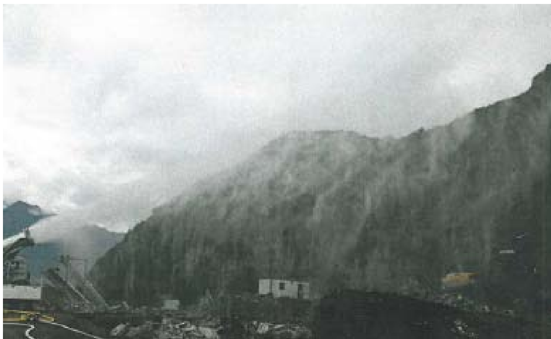
Figura 70 - “Cannone ad acqua” per l'abbattimento delle polveri con pressione dell'acqua variabile
