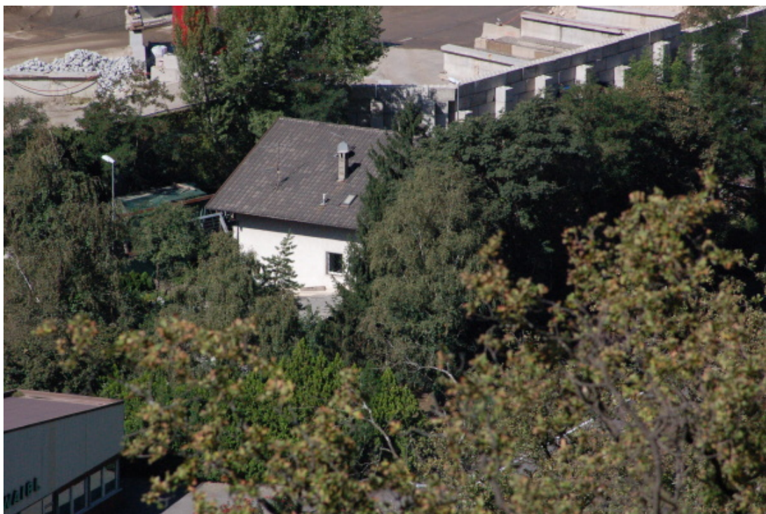
Figura 58 - Muro perimetrale provvisorio.
