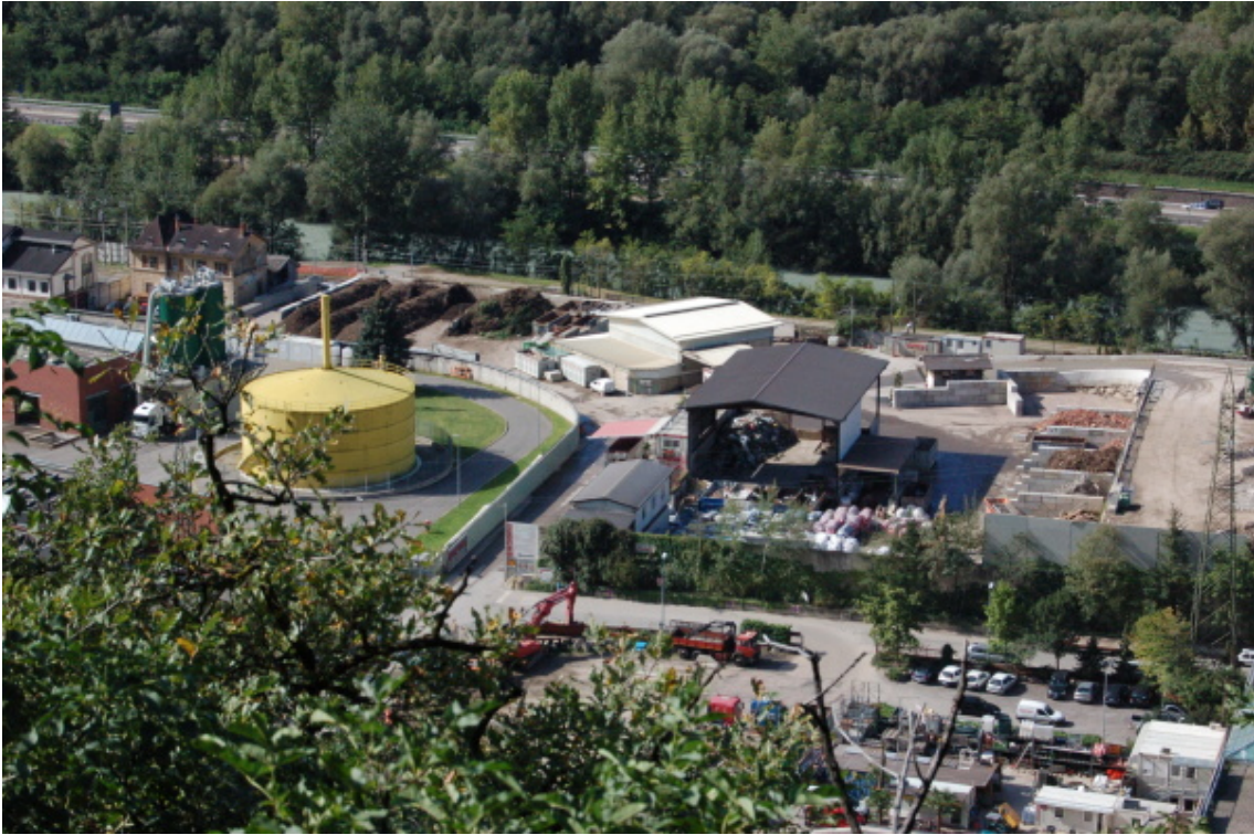
Figura 10: Compostaggio ERDBAU, ingresso areale e area di deposito ERDBAU
