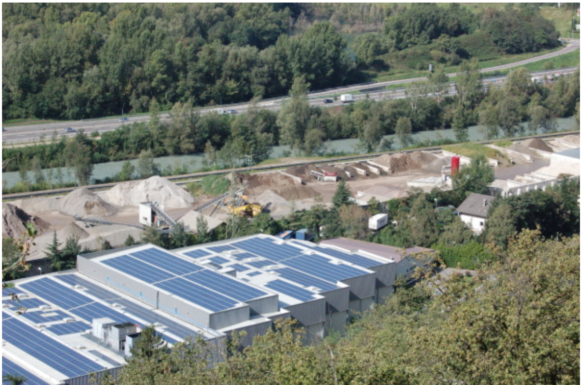
Figura 13: Area lavorazione terre ERDBAU e stoccaggio in box aperti
