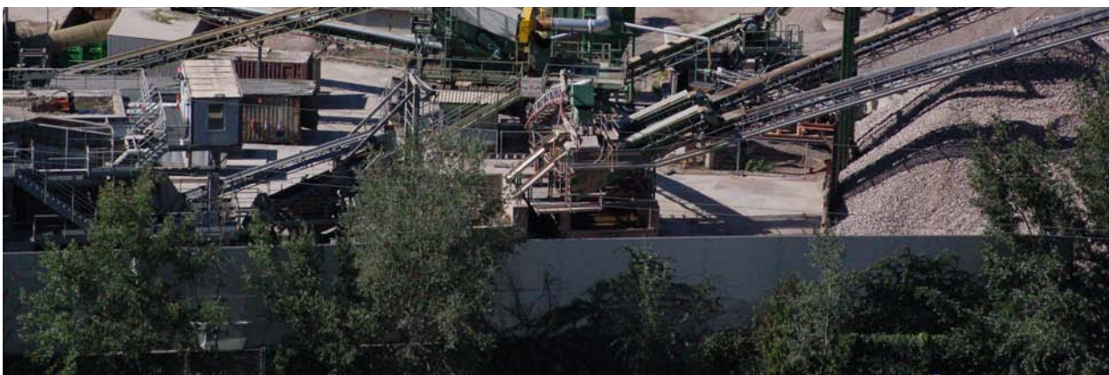
Figura 62 - Muro perimetrale lungo la via Montecatini a protezione del rumore prodotto dai nastri trasportatori
