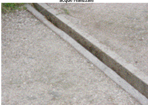
Illustrazione 2 – Un particolare delle opere di regimentazione delle acque realizzate
