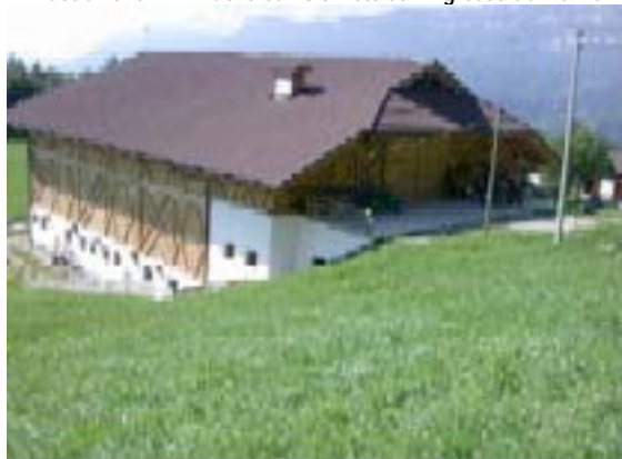
Illustrazione 2 – Il nuovo edificio visto dall'ingresso del fienile
