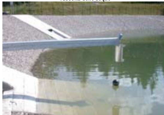
Illustrazione 1 – Un particolare del “troppo pieno” del bacino di raccolta delle acque
