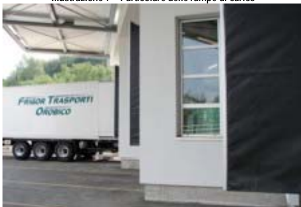
Illustrazione 7 – Particolare delle rampe di carico
