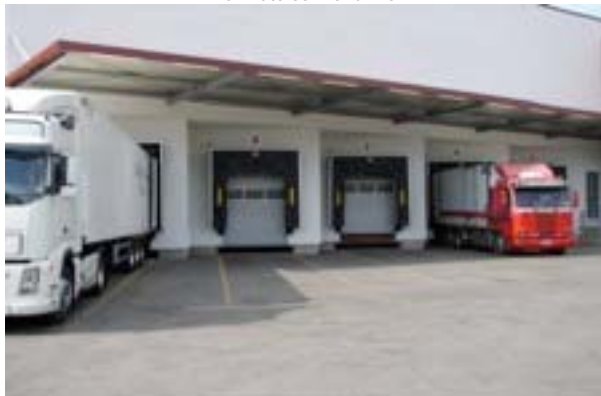
Illustrazione 6 – Le rampe per il carico dei camion sono un intervento finanziato con fondi PSR
