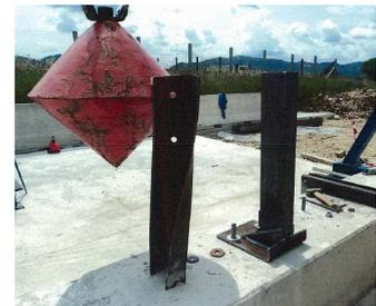
Sie dienen zur Vervollständigung der Installation und müssen abseits möglicher Fahrwege positioniert werden, um den Rampeneffekt zu vermeiden.
